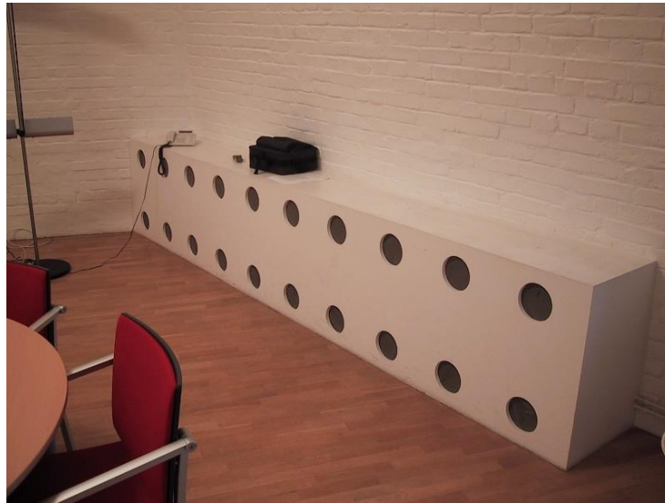
15 pav. Helmholtzo rezonatorius panaudotas slopinti, dėl stipriai garsą atspindinčių mūrinių sienų, atsiradusį patalpos rezonavimą.
