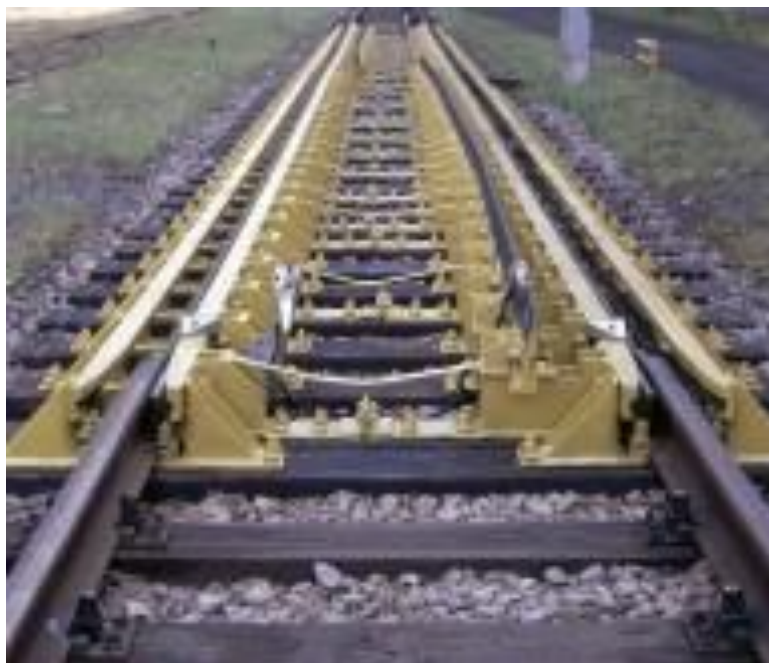
2.10 pav. Ant geležinkelio kelio įrengtas SUW 2000 vėžės pločio keitiklis [31]
