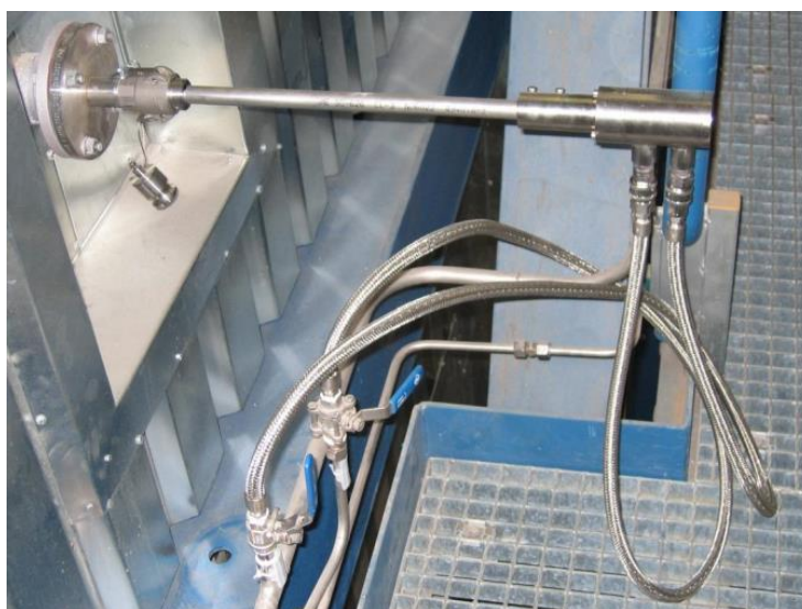
14 pav. Įpurškimo vamzdelis su karbamido tirpalo bei suspausto oro vamzdžiais
