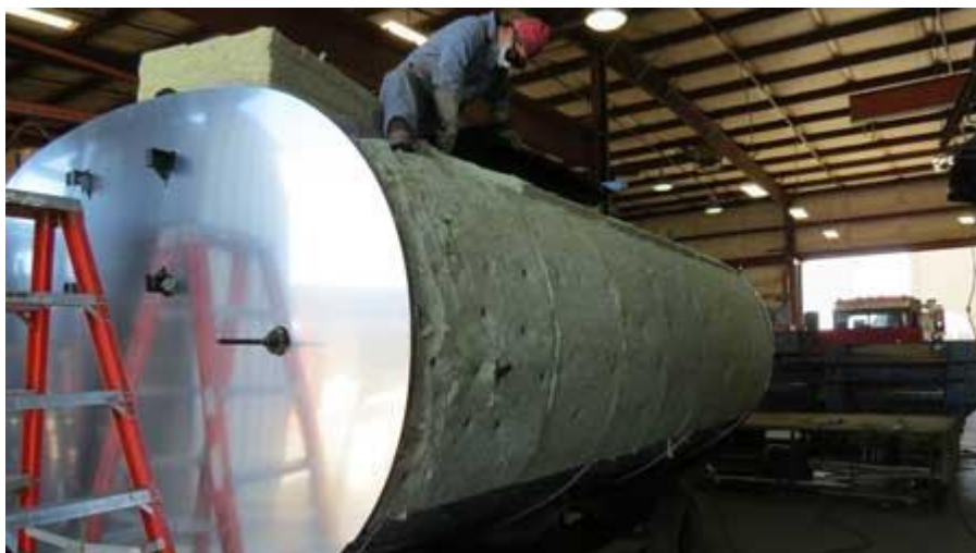
2.1 pav. Cisternos padengimas izoliacinėmis medžiagomis
