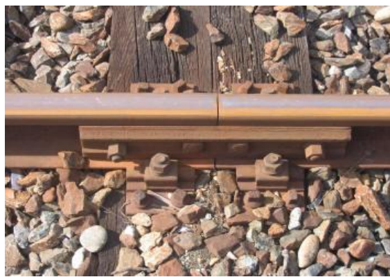
1.17b pav. Bėgių sujungimas ant suporintų pabėgių [45]
