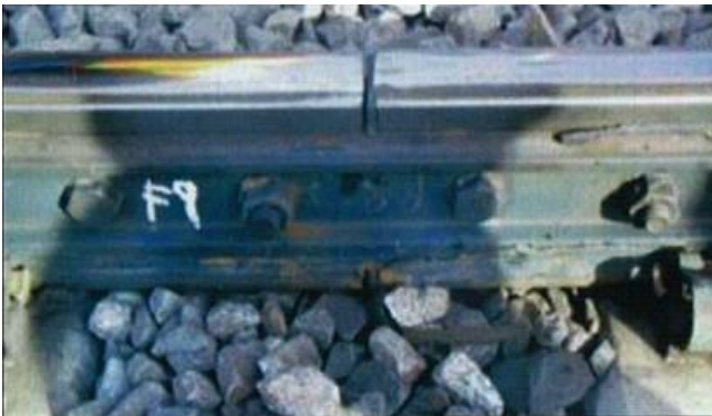
2.16 pav. Deformuotas tarpiklis [17]
