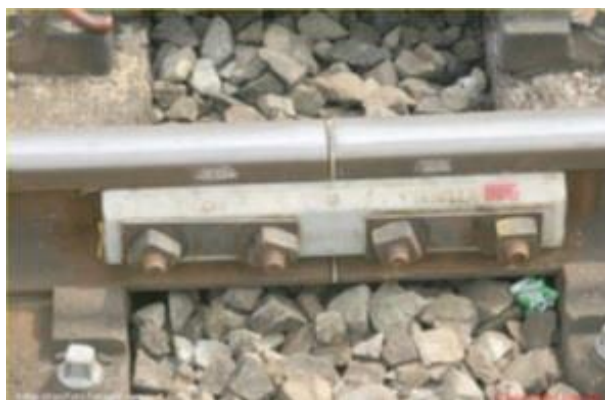
1.17a pav. Bėgių sujungimas, kai sandūra tarp dviejų pabėgių [44]
