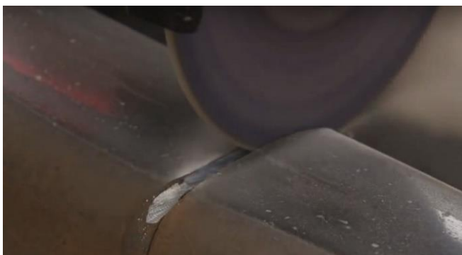
2.10 pav. Bėgio metalo pertekliaus šalinimas iš sandūros zonos kampiniu šlifuokliu [48]
