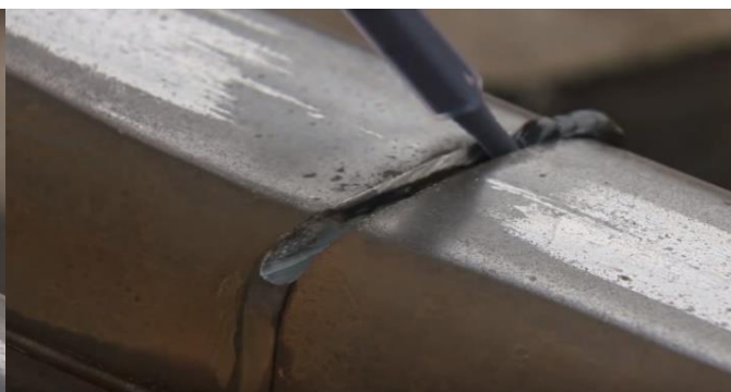
2.11 pav. Tarpelio užpildymas izoliuojančia medžiaga [49]
