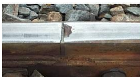
2.8 Bėgio galvutės ištrupėjimas [22]
