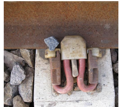
1.8 Pandrol Fastclip tipo sąvarža [41]
