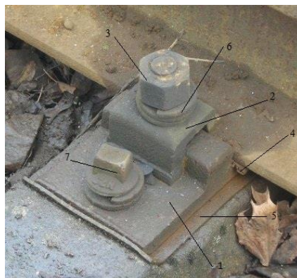
1.5 pav. KB tipo sąvarža [41]: 1- padėklas; 2 – gnybtas; 3 – varžlė; 4 – tarpinė po bėgio padu; 5 – tarpinė po padėklu; 6 – spyruoklinė poveržlė; 7 – įdedamasis varžtas
