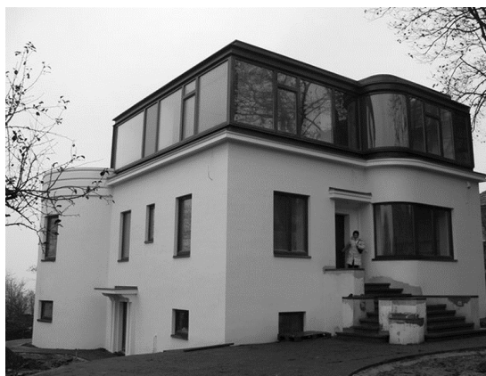
7pav. D.Trainauskas ir L.Janušaitienė "Pastatas po renovacijos"
