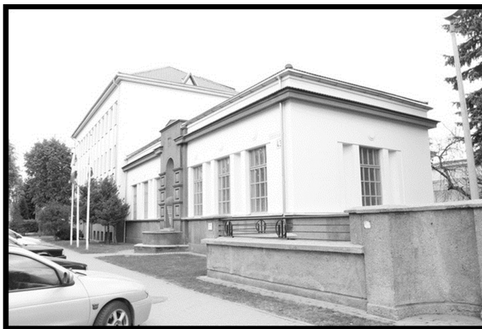
22 pav. Žaliakalnio vandentiekio stotis
