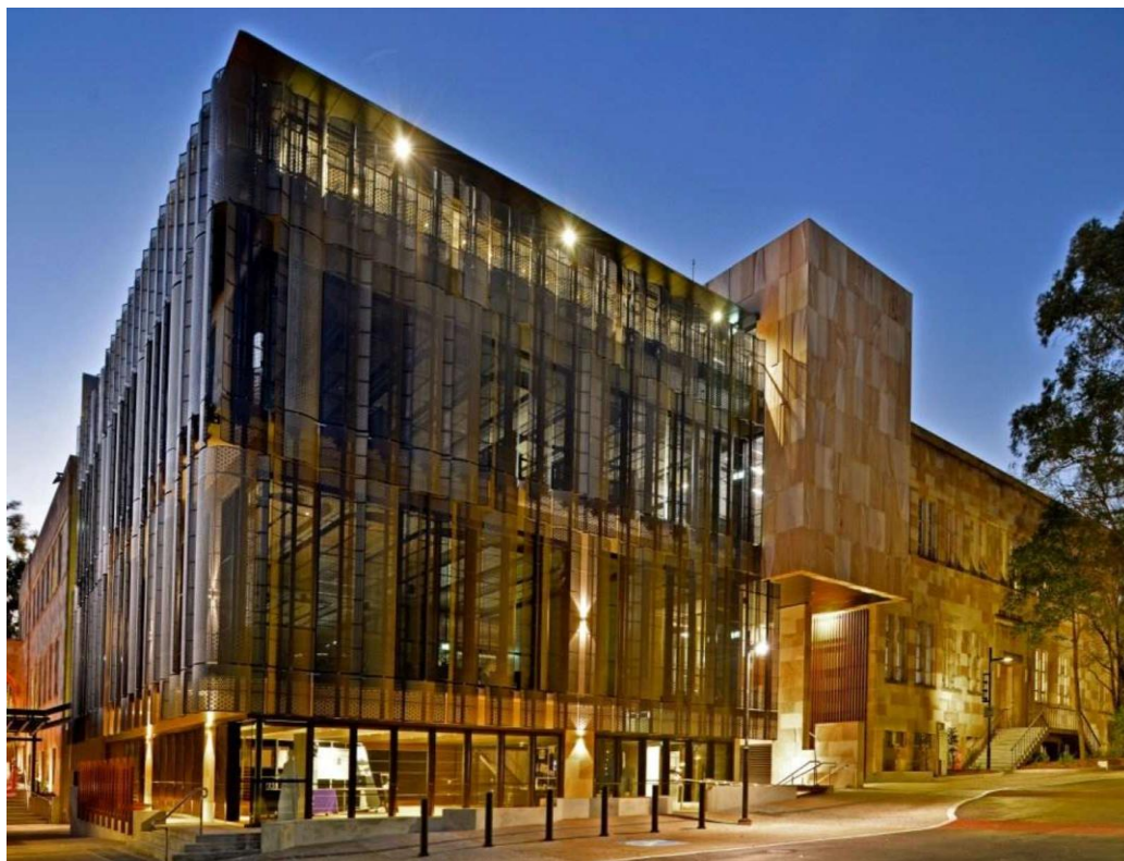
6 pav. Pirmasis pasaulyje statinys iš geopolimerinio betono Klimato Kaitos institutas Australijoje
