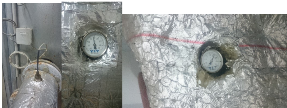
2.1.4 pav. Temperatūros reguliatorius ir įtraukiamo, išpučiamo oro temperatūrų parodymai
