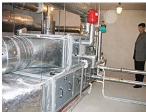
1.3.2 pav. Pakruojo miesto ligoninės operacinės ir reanimacijos skyriaus ventiliacinė sistema
