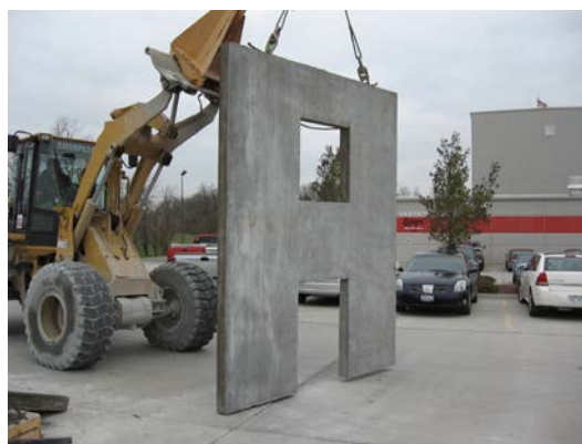
7 pav. Sieninė plokštė pagaminta iš lengvojo betono.
