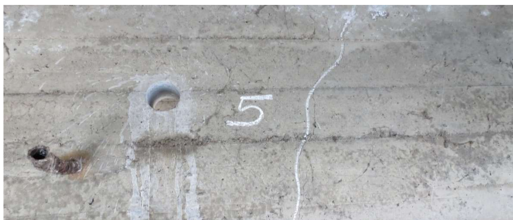
2.6 pav. Išgręžtas betoninis kernas iš pirmojo tarpatramio perdangos penktos pagrindinės sijos
