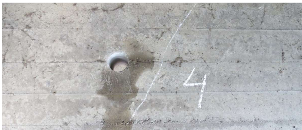
2.5 pav. Išgręžtas betoninis kernas iš pirmojo tarpatramio perdangos ketvirtos pagrindinės sijos
