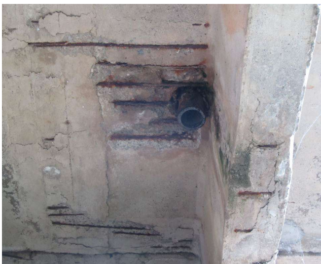
1.3pav. Šulinėlių įrengimo klaidos
