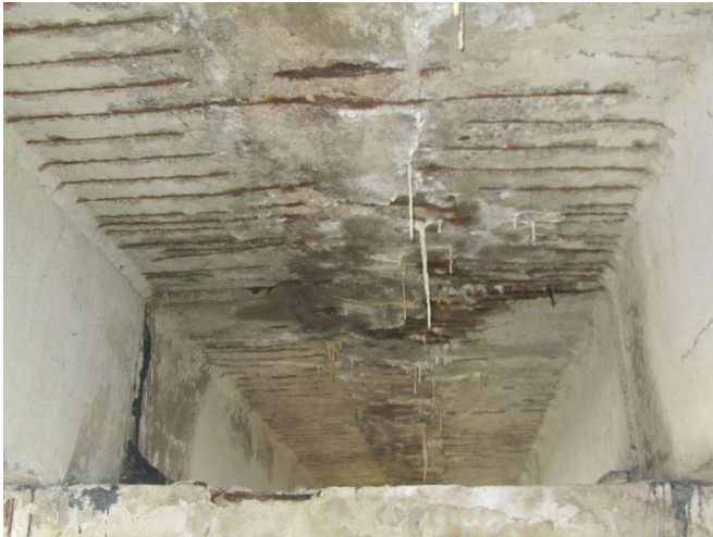
1.2 pav. Kiauros hidroizoliacijos pažaidos
