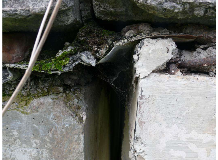
1.4pav. Deformaciniai pjūviai
