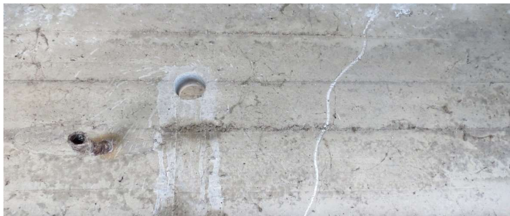
2.4 pav. Išgręžtas betoninis kernas iš pirmojo tarpatramio perdangos trečios pagrindinės sijos
