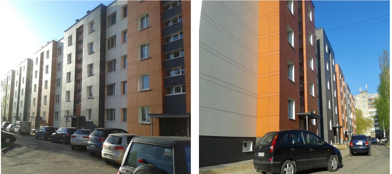
20 pav. Modernizuoto daugiabučio gyvenamojo namo fasadai
