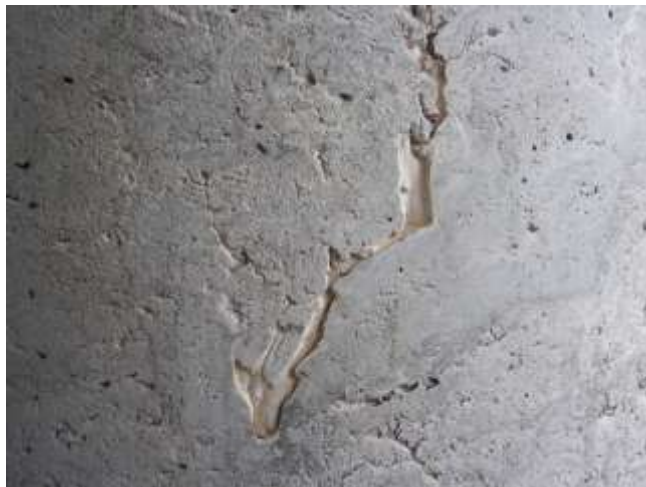
1.6 pav. Išplauta cemento tešla klojinių sienelių paviršiuje (autoriaus nuotrauka)
