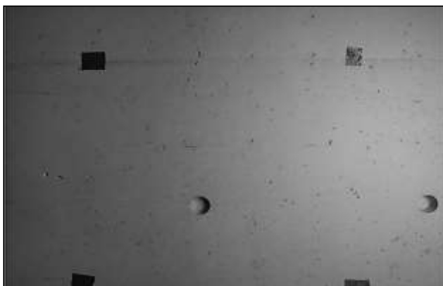
2.6 pav. „Realfagbygget“ pastato monolitinės sienos fragmentas
