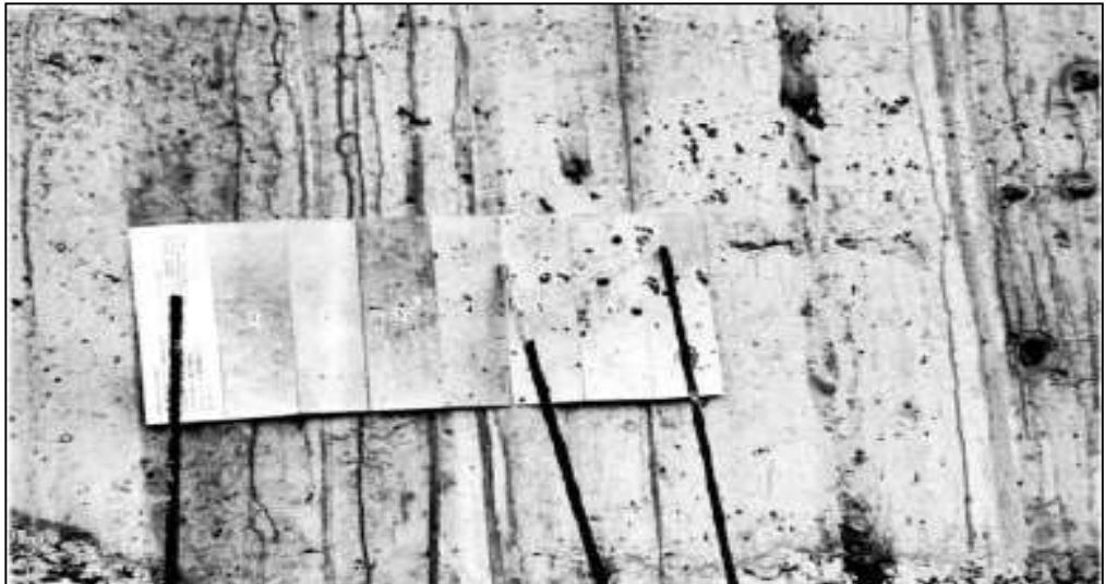
1.9 pav. Betono paviršiaus kokybės vertinimas pagal CIB standartą (CIB Report no. 24CIB Report no. 24, 1973)
