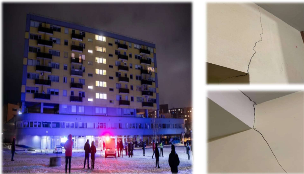
6 pav. Defektai, atsiradę dėl netolygaus pamato sėdimo pastate Gabijos g. Vilniuje
