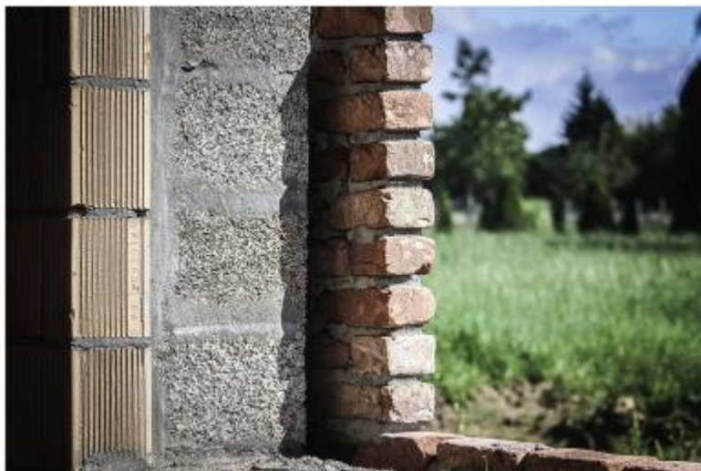
14 pav. Surenkami kanapių betono blokai, naudojami kaip laikančios mūro konstrukcijos izoliacinis sluoksnis [44]
