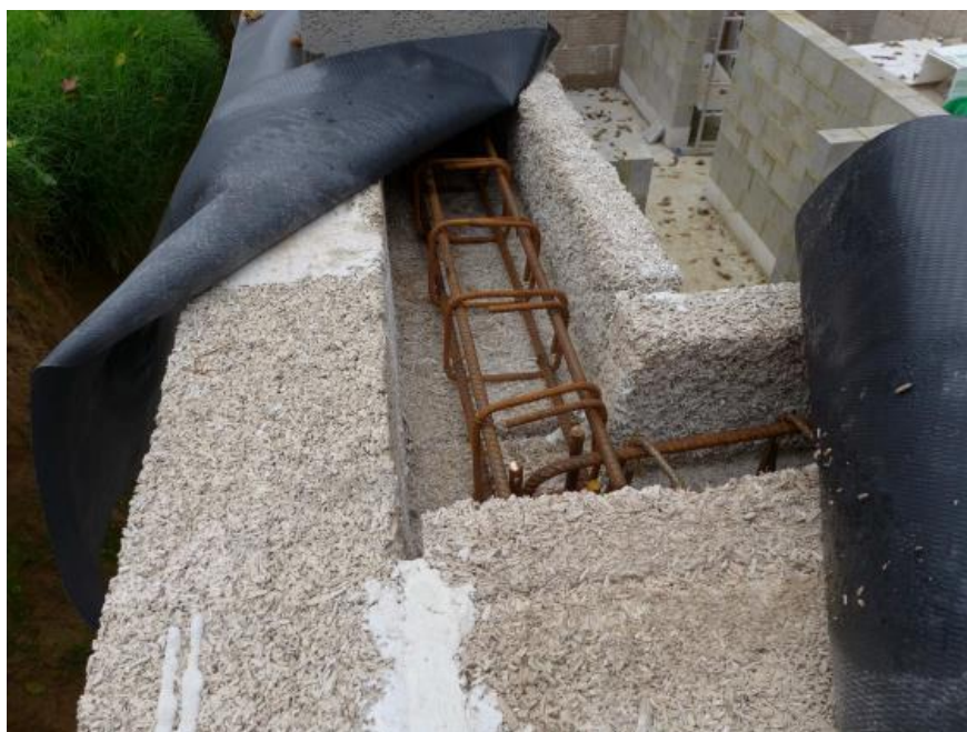
15 pav. Kanapių betono panaudojimas namo sienų statybai [32]
