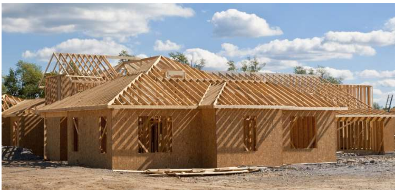
5 pav. Medinio karkasinio pastato pavyzdys [8].
