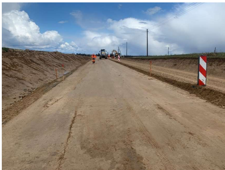
10 pav. Atliktas sankasos stiprinimas cementu [sudaryta autoriaus]
