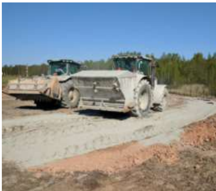
12 pav. Mechanizmai reikalingi sankasos gerinimui kalkėmis (kairėje traktorinė freza, dešinėje traktorinis kalkių paskleistuvas) [54]
