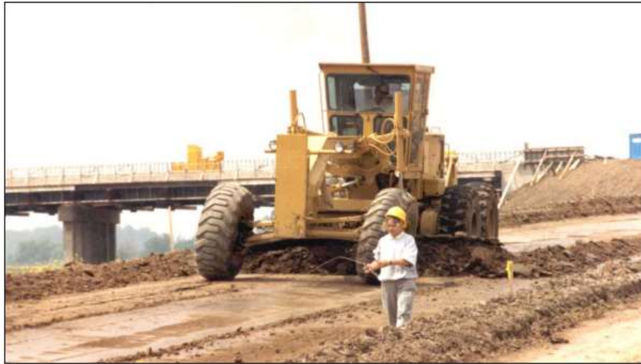
4 pav. Greideriavimas [16]
