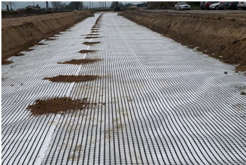
18 pav. Geotekstilės su geotinklu paklojimas [sudaryta autoriaus]
