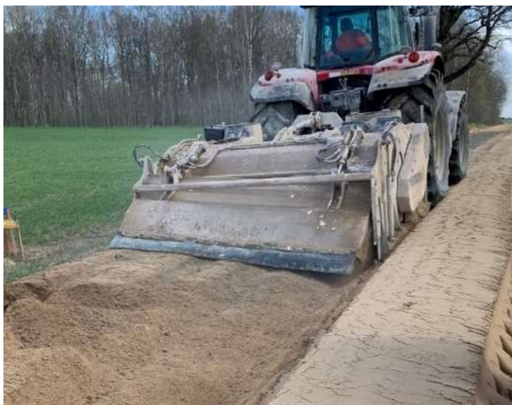
20 pav. Sankasos frezavimas [sudaryta autoriaus]
