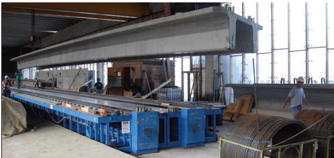
5.6.1.8 pav. TT plokštės iškėlimas
