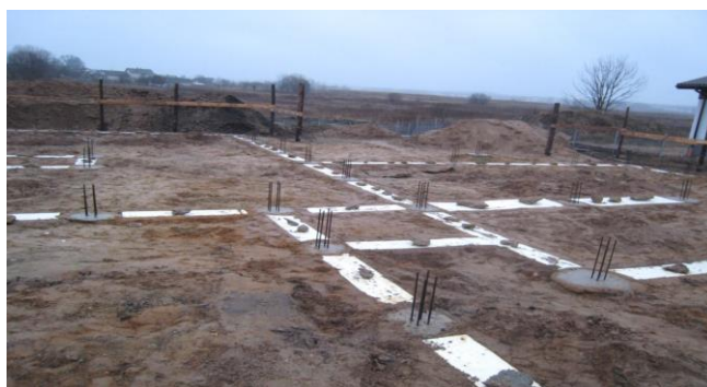
3.9 pav. Gręžtiniai poliai išbetonavus ir sudėjus armatūros karkasą
