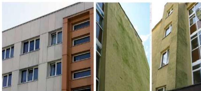
2.5.2 pav. Fasadų užteršimas mikroorganizmais
