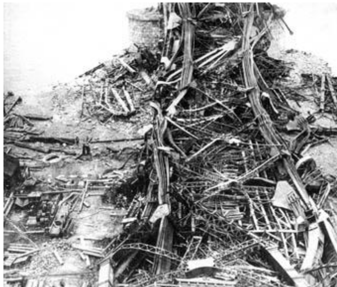
1.2 pav. Kvebeko tilto griūtis 1907 m. [4]
