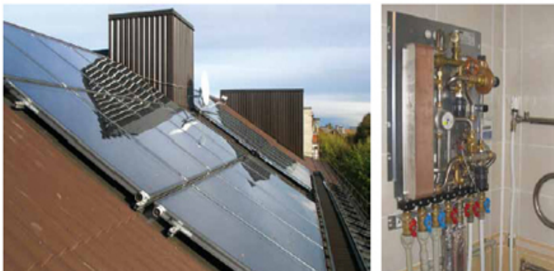
2.6 pav. Daugiabučio gyvenamojo namo ant stogo pritvirtinti saulės kolektoriai [12]
