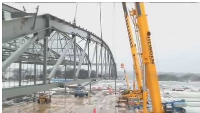
4.21 pav. Konstrukcijos kėlimas ant atramų. [65]
