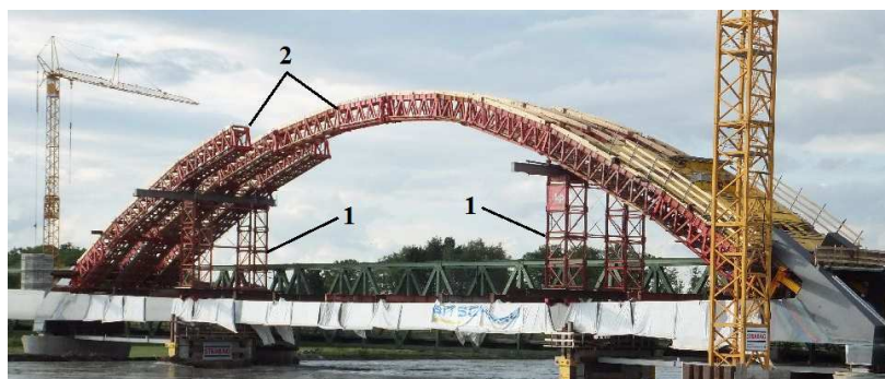
4.10 pav. „RMD Kwikform“ erdvinių atramų sistema [50]: 1 – atraminiai bokšteliai; 2 – erdvinių atramų segmentai.
