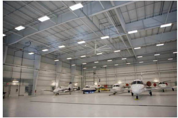
4.15 pav. Lėktuvų angaro laikančiosios konstrukcijos. [58]
