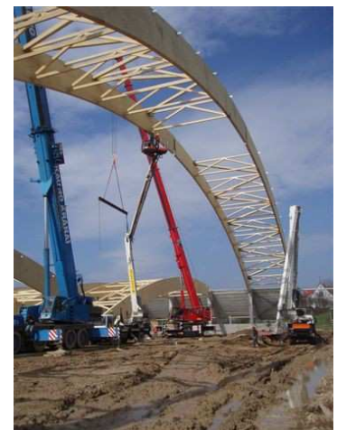
5.9 pav. Pusarkių montavimo proceso eiga. [59]
