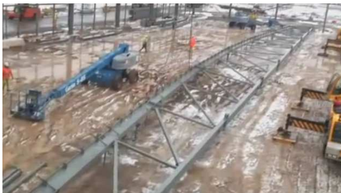
4.20 pav. Konstrukcijos dalių sujungimas ant žemės. [65]
