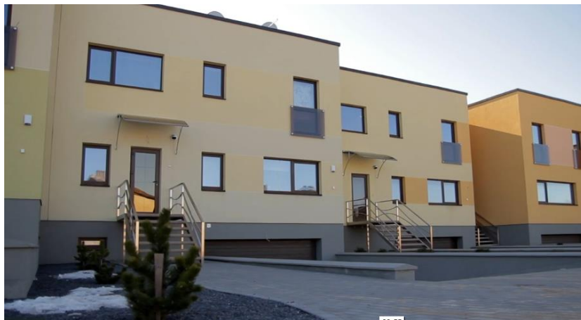
1.13 pav. Pastatas šiltintas termoizoliaciniu tinku ir dažytastermokeraminiais dažais.
