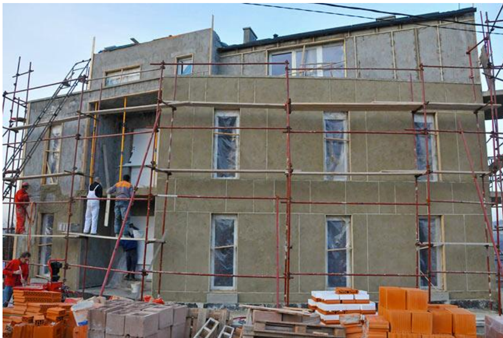
1.11 pav. Termoizoliaciniu tinku šiltinamas pastatas
