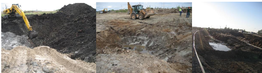
2.2 pav. Žemės darbai, aikštelės paruošimo darbai.
