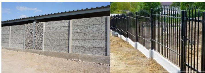
2.7 pav. Betoninė tvora. Metalinė segmentinė tvora su betoniniais pagrindais, betoninių pamatu.
