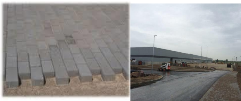
2.5 pav. Betoninių trinkelėlių danga. Asfaltbetonio danga.
