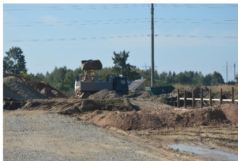
2.1 pav. Aikštelės paruošimas žemės darbams. Laikinių kelių suformavimas iš trupinto betono skaldos.
