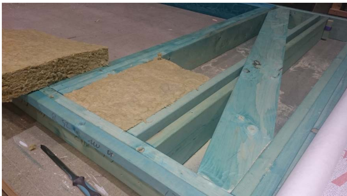
1.2 pav. Skydinio namo elementas, su pradėta dėti šilumine izoliacija.
