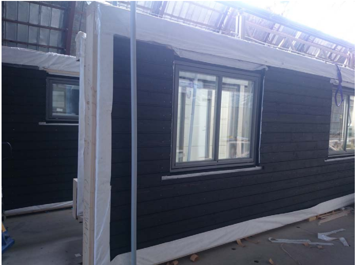
1.3 pav. Skydinio namo elementas, su išorės apdaila ir įmontuotu langu.
