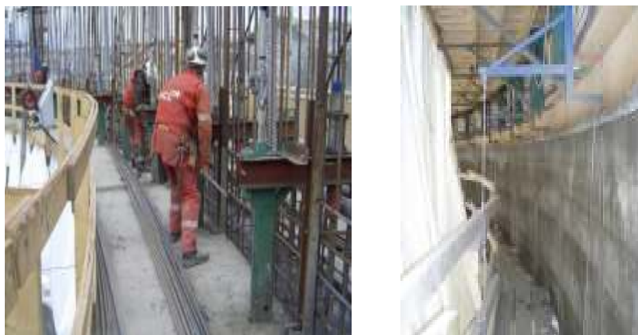
3.3 pav. Viršutinė ir apatinė darbo aikštelės, [13].
