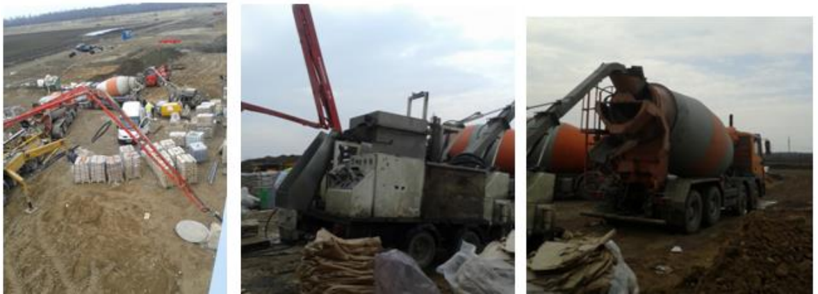
1.7 pav. Betono mišinio gamyba statybos aikštelėje
