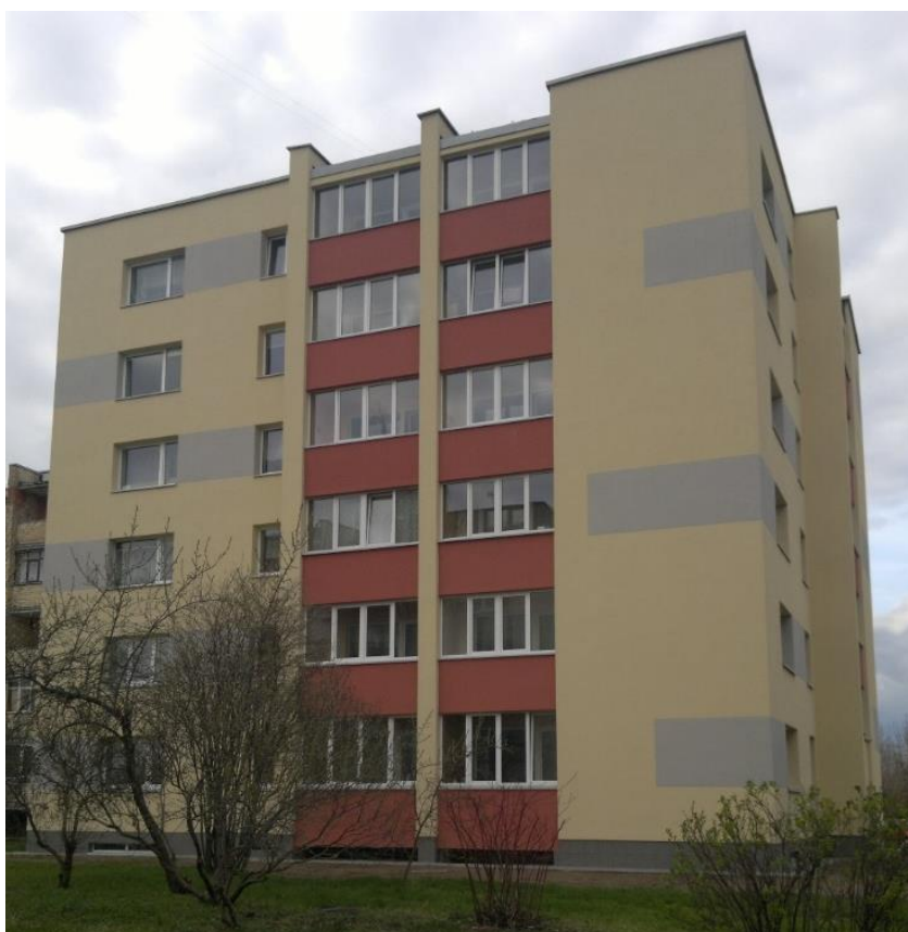
3.25 pav. Renovuoto namo fasadas
