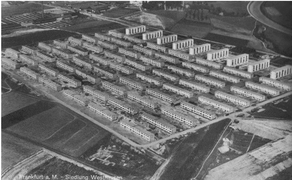
Fig. 3. Siedlung Westhausen in Frankfurt, Germany
