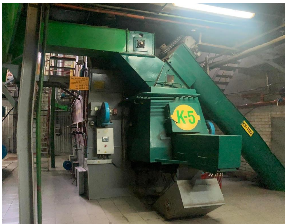
6 pav. Vandens šildymo katilo „Kaistra 4500“ priekinė dalis
