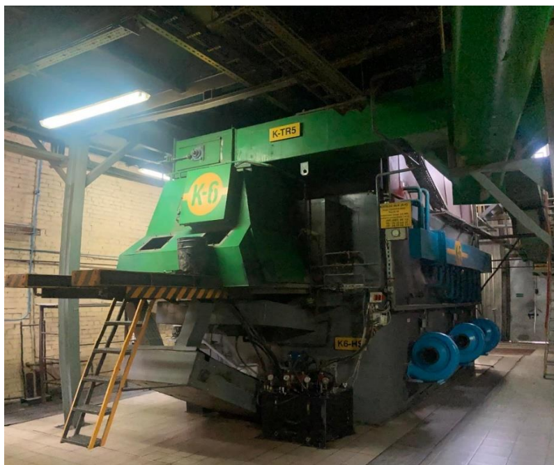
7 pav. Vandens šildymo katilo „Kaistra 6000“ priekinė dalis
