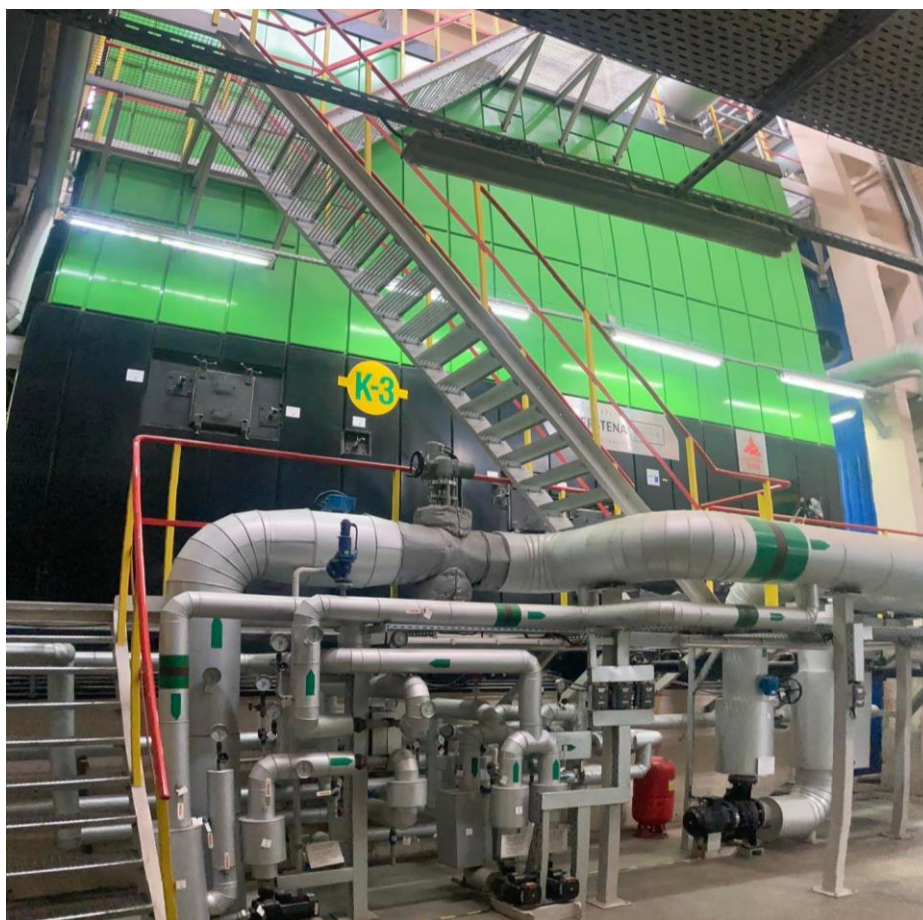
9 pav. Katilo K-3 pakuros šoninis vaizdas
