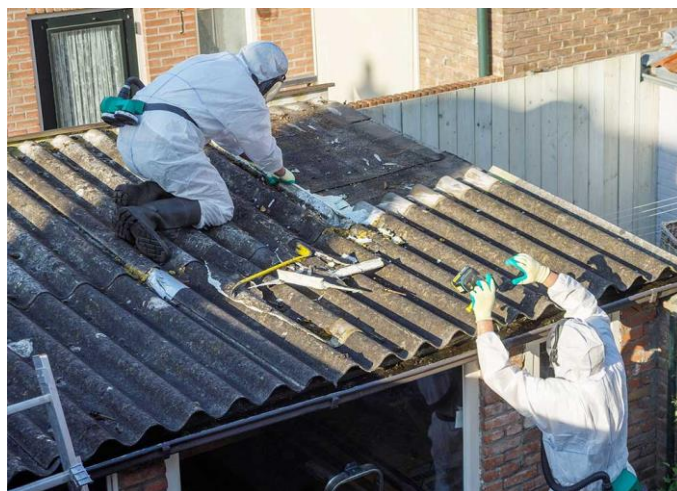
4 pav. Asbestinio šiferio demontavimas.
