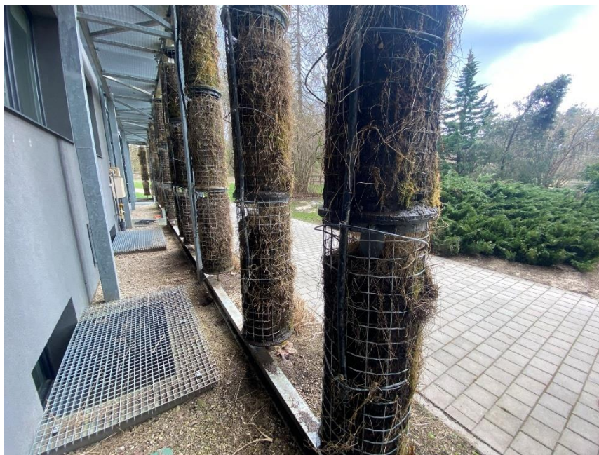
50 pav. Smunkantis substratas.
