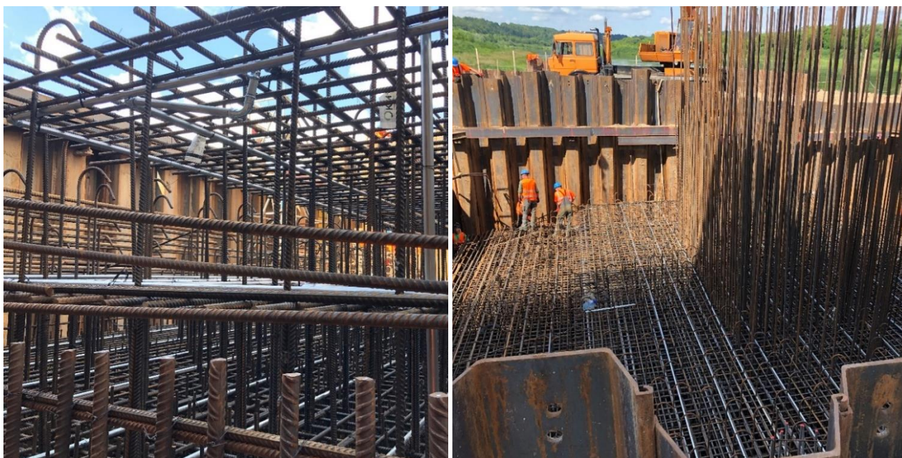
16 pav. Rostverko armatūros ir aušinimo vamzdelių išdėstymas prieš betonavimo darbus
