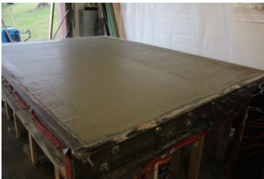
4 pav. Tiltų konstrukcija po betono mišinio paklojimo [32]
