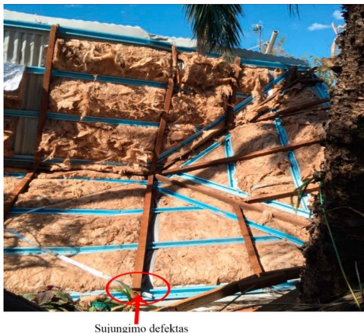
12 pav. Stogo konstrukcijų sujungimo defektas [14]
