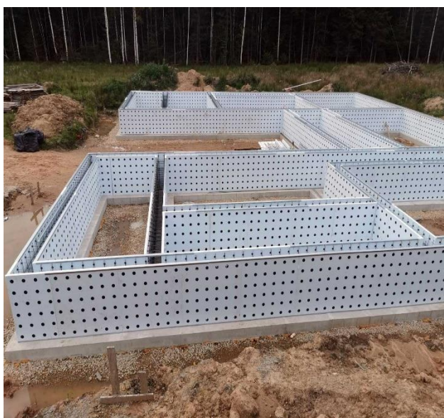
25 pav. Pamatai iš liktinių klojinių „TenaPors – Dobeles panelis“ [1.24]
