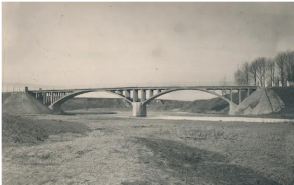
2 pav. Arkinis gelžbetoninis tiltas (Kumelionių tiltas) [1]
