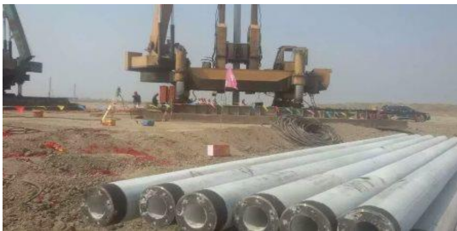
24 pav. Iš anksto įtempto polio montavimas [18]
