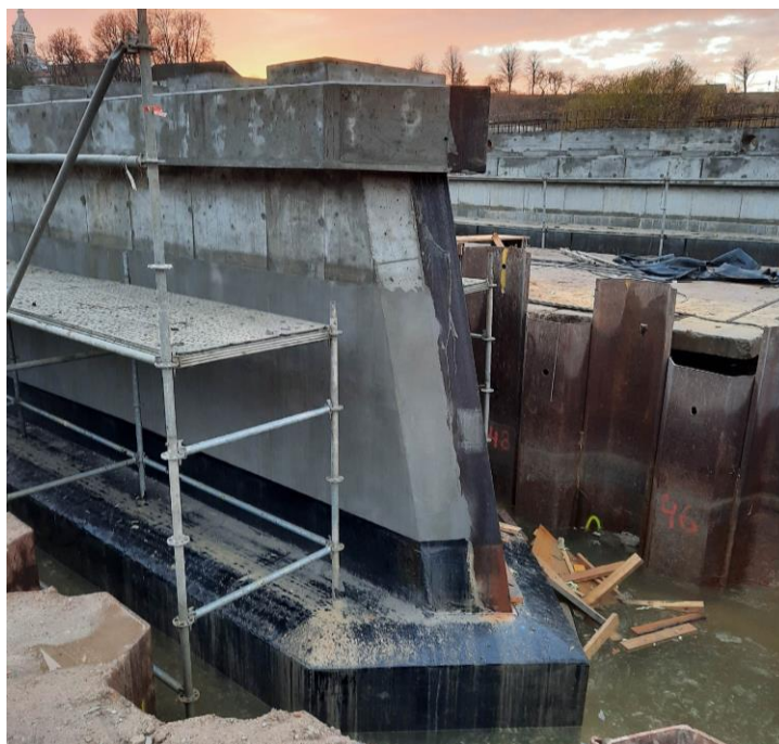
22 pav. Stiebas jungiantis rostverką ir rigelį [autoriaus nuotrauka]
