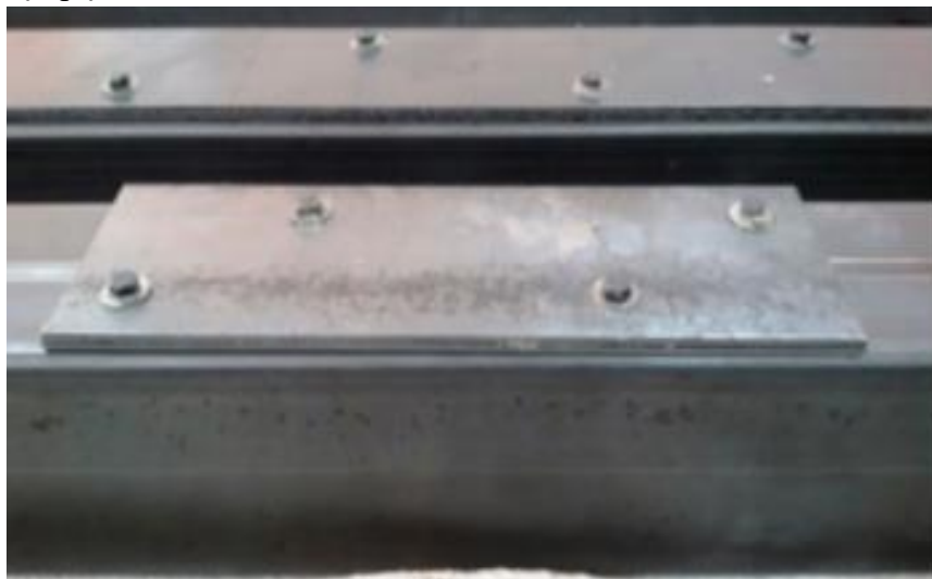
15 pav. Uždaro profilio stiprinimas plokštelėmis naudojant varžtus [9]
