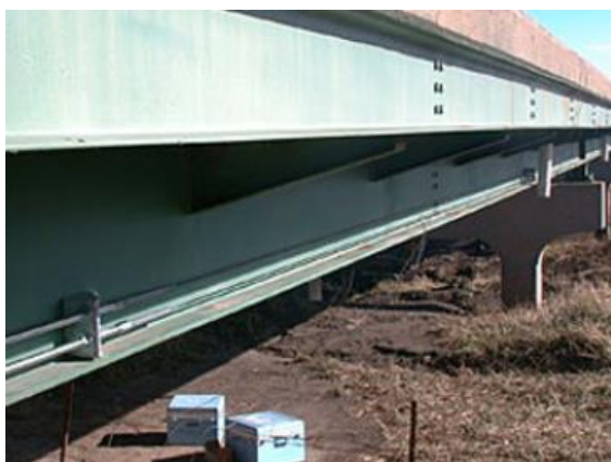
21 pav. Įtemptų lynų panaudojimas tiltų plieninėse konstrukcijose
