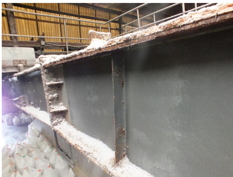
4 pav. Trąšų sandėlio plieninio rėmo padengimas
