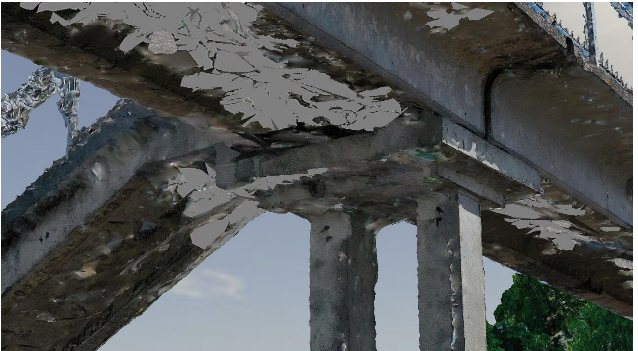
18 pav. Sugeneruotas tilto apačios fotogrametrinio 3D modelio vaizdas
