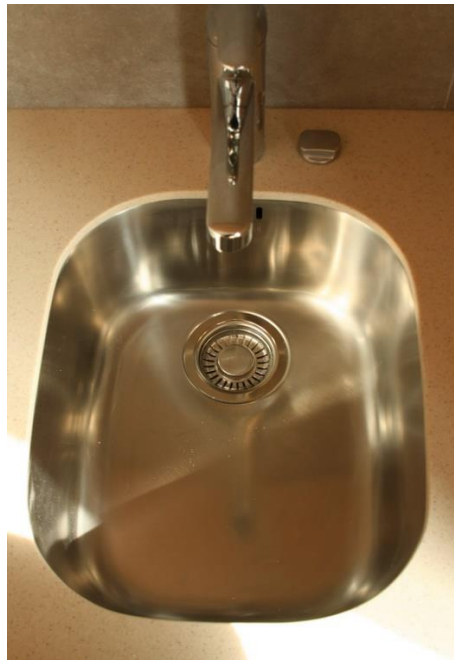
6 pav. Nerūdijančio plieno praustuvas įmontuotas į dirbtinio lieto akmens stalviršį
