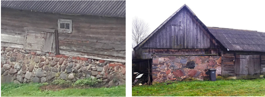
85 pav. a, b) ūkio pastato pamatų fragmentai; c) tašyto akmens mūras ūkio pastato sienoje. 2016 m. nuotraukos
