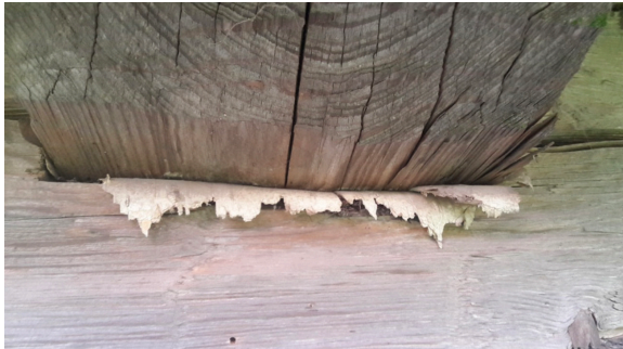
87 pav. Beržo tošis po sija. Veliuonos v., Žardiškių k.
