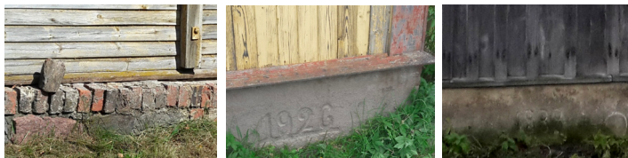
68 pav. Gyvenamųjų namų pamatų fragmentai: a) tradicinis akmenų mūro, b) betono, c) akmenų mūro, tinkuotas. 2017 nuotr.
