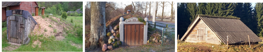
82 pav. Kiemo rūsiai: a) lieto betono 1931 m., b) mūro 1926 m., c) rąstinis. (Zapyškio, A. Panemunės, Seredžiaus v. 2016m. nuotr.)
